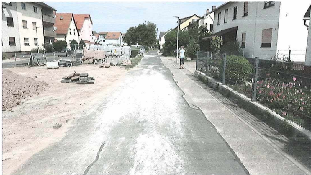
Foto 3: südliche Hälfte im westlichen Bereich des Binsenwegs
