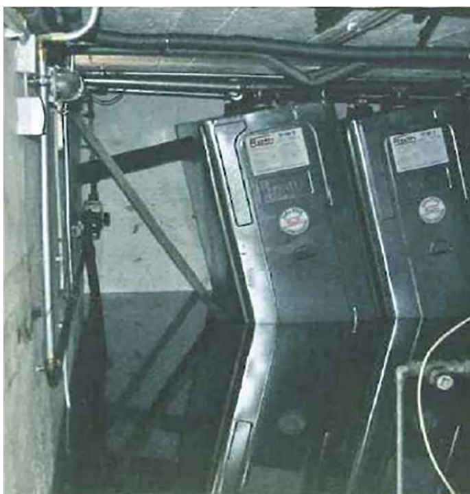
Heizöltanksicherung nach dem Prinzip „Wasser fernhalten“
